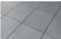
Estrichbetonplatten grau (im Gefälle, Platten mit offenem Fugenbild)
