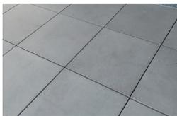
Betonplatten grau im Splittbett verlegt (ohne Gefälle)
