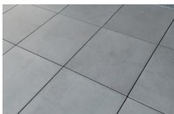
Betonplatten grau (im Gefälle verlegt)
