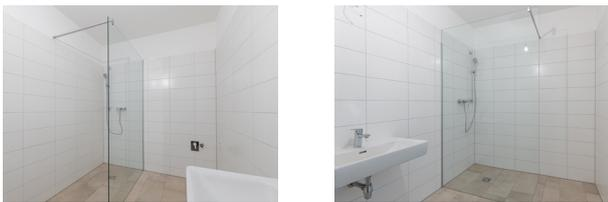
Größe 90/130 cm bodeneben verflies mit Entwässerungsgully, seitliche Glas-Duschwand (Länge ca. 130 cm, Höhe ca. 200 cm) mit offenem Einstieg (ohne Türe) Aufputz-Einhebel-Brausebatterie samt Schlauchbrausegarnitur mit Wandstange.
