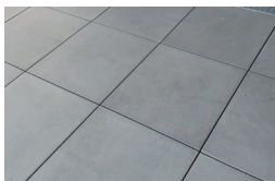
Estrichbetonplatten grau (im Gefälle, Platten stumpf gestoßen bzw. mit offenem Fugenbild)
